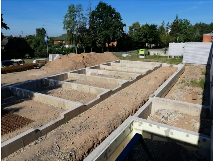
Laboratoriju kompleksa ar klimata regulēšanas iespējām izbūve
