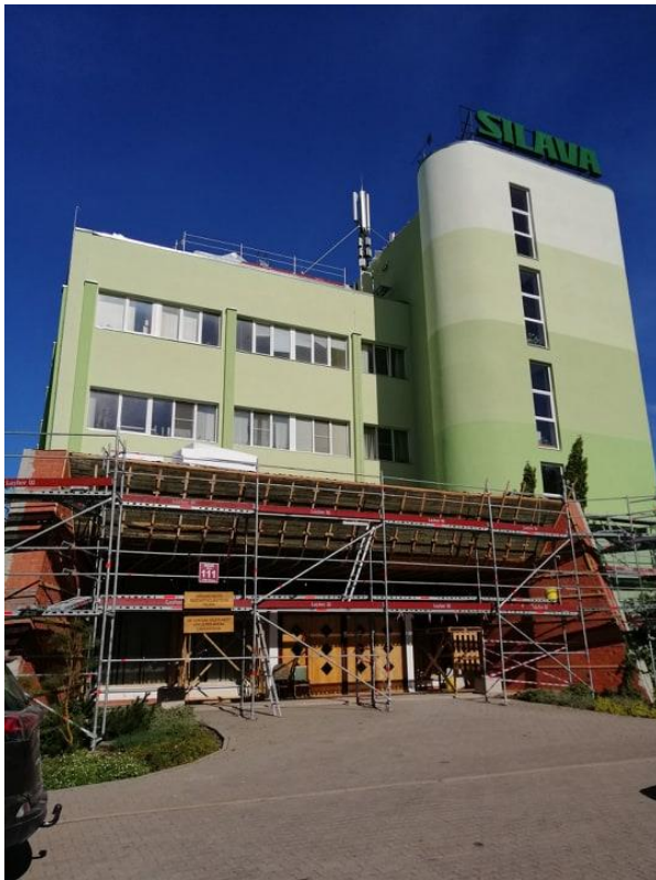
LVMI "Silava" centrālās ēkas fasādes vienkāršota atjaunošana
