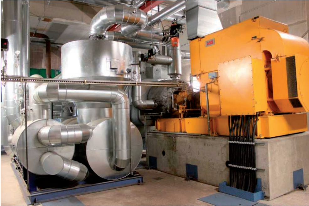
63. attēls. ORC sistēma (1,520 kW el ), Grunfüttertrocknungsgenossenschaft Kirchdorf a.H. eG Vācijā (Avots: D. Rutz).
