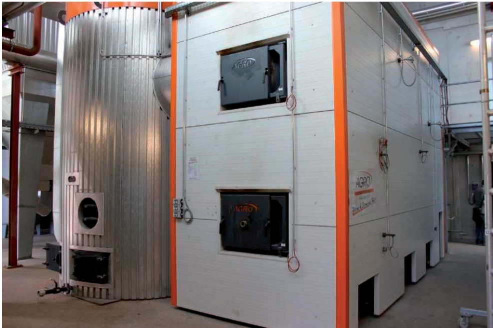
62. attēls. Vidēja izmēra šķeldas apkures sistēma (3000 kW jauda) ar apkures katlu (pa labi) un siltuma akumulācijas tvertni (pa kreisi), Biomassehof, Ahentāle, Vācija (Avots: D. Rutz).
