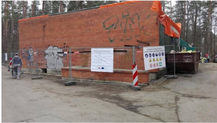
Būvdarbi pētnieciskās infrastruktūras izveidei Institūta ielā 6/1
