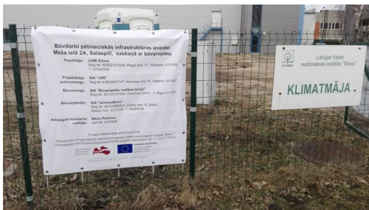
Būvdarbi pie Klimatmājas laboratoriju kompleksa izbūvei
