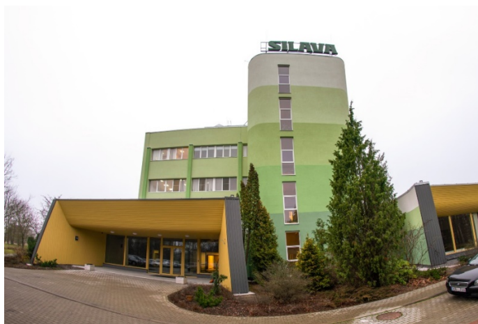
LVMI Silava centrālās ēkas fasādes vienkāršota atjaunošana
