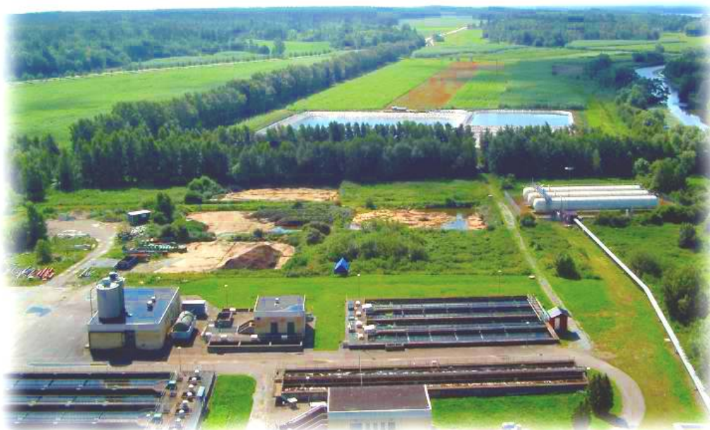
24. Attēls: Kārklu biofiltrācijas lauki pie Jončepingas notekūdeņu attīrīšanas ierīcēm.
