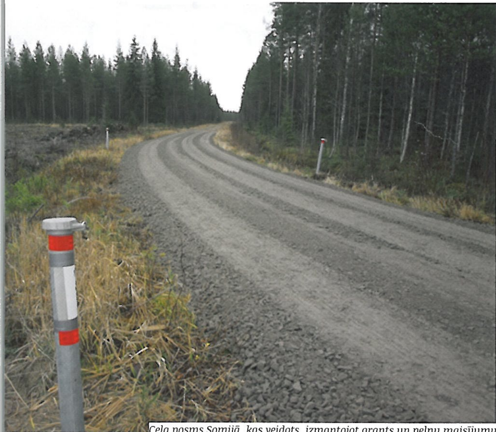
Ceļa posms Somijā, kas veidots, izmantojot grants un pelnu maisījumu
